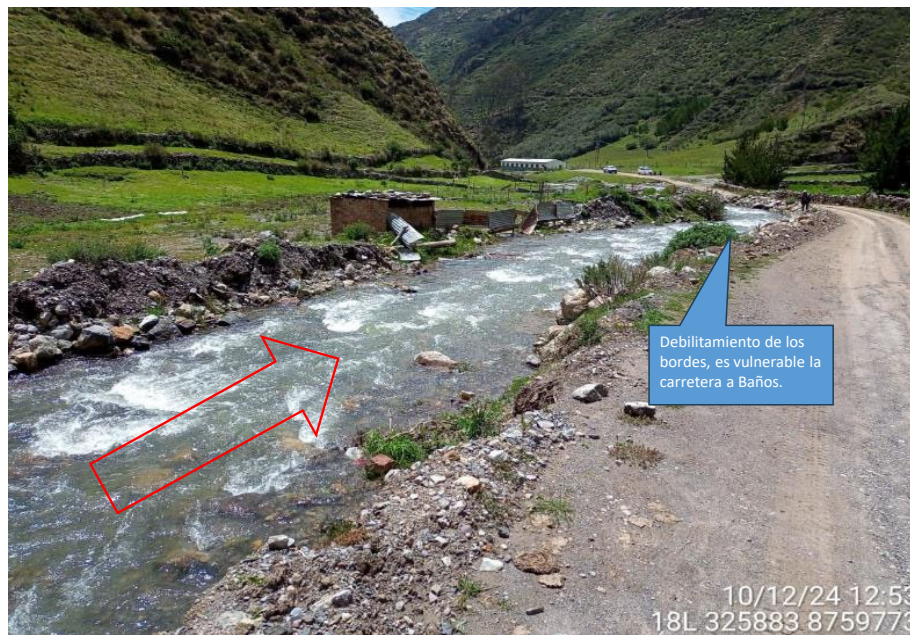
FIGURA N°03: EN LA TEMPORADA DE MAXIMAS AVENIDAS, EL RIO BAÑOS SE SEDIMENTA EN SECTOR CHUCHURA SE DESVIA AMBAS MARGENES OCACIONANDO, DETERIORO DE LA CARRETERA.
